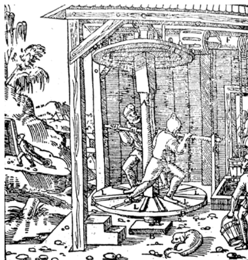
图 7-7 踏车驱动的绞盘，采自沃尔夫《十六、十七世纪的科学、技术与哲学史》
